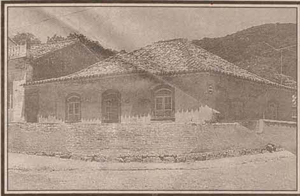
Casa de Anita, ao lado da Igreja Matriz de Santo Antônio dos Anjos, em 1969.
